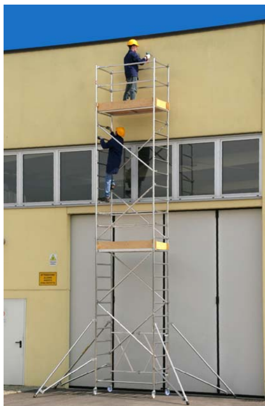
ROLLER S MONTATO ALL'ALTEZZA MASSIMA DI M 7,10
