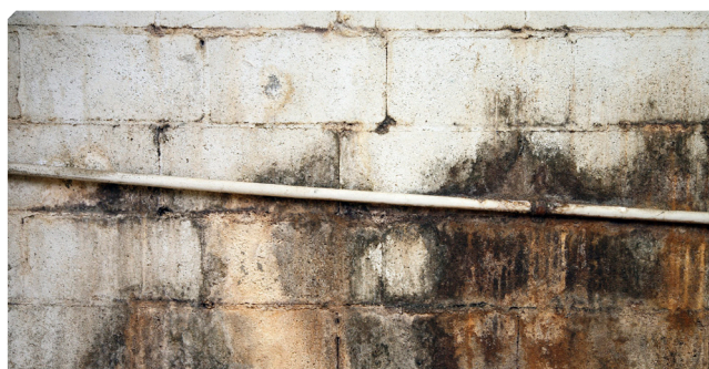
■ Umidità e microrganismi sopra il supporto
