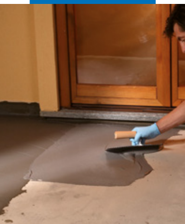
Impermeabilizzazione di terrazzo a spatola
