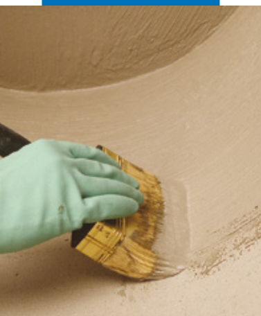
Impermeabilizzazione di dettagli a pennello
