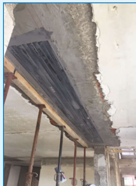
Trave rinforzata con Carboplate System
