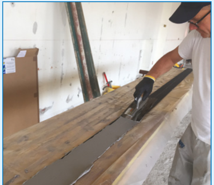
Applicazione di MapeWrap 11 / 12 o Adesilex PG1 / PG2 sulla lamina Carboplate
