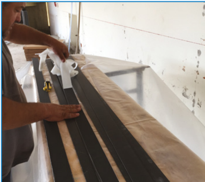
Rimozione delle pellicole protettive dalla lamina Carboplate
