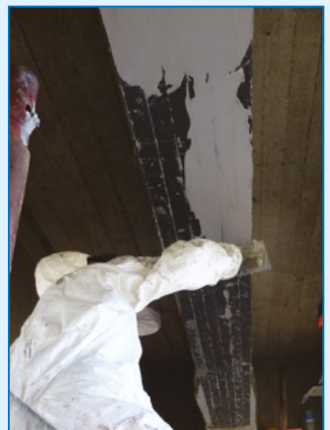
Rasatura con MapeWrap 11 / 12 o Adesilex PG1 / PG2 per successiva finitura
