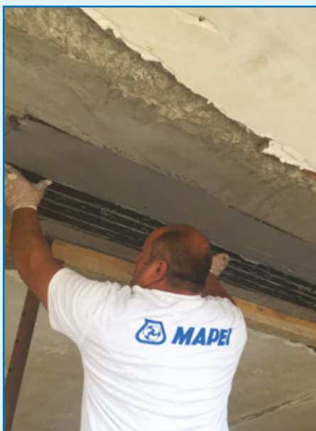
Applicazione della lamina Carboplate
