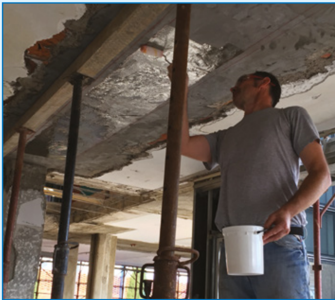
Applicazione di MapeWrap Primer 1
