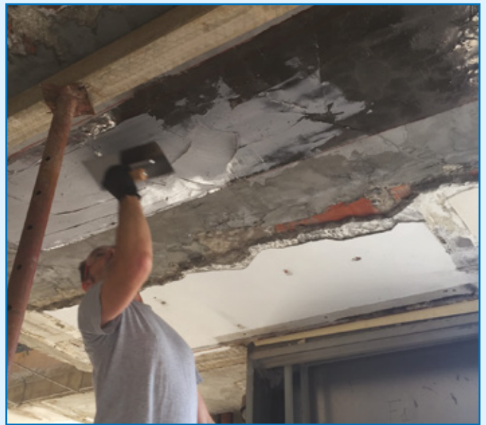
Applicazione di MapeWrap 11 / 12 o Adesilex PG1 / PG2 sul supporto
